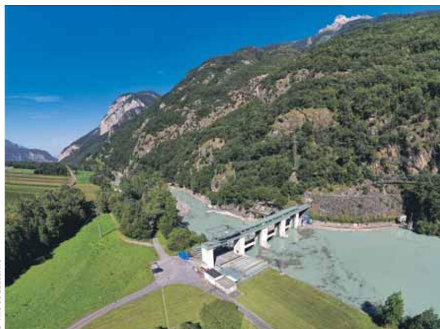
La force du Rhône permet de produire de l'électricité à Lavey pour le réseau lausannois.
